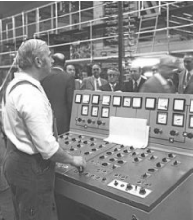
Die moderne Technik erklärt Gustav Klose den Gästen am Leitstand der neuen Rotation, die 96 Seiten nun in einem Durchgang drucken kann. Foto: BNN-Archiv
