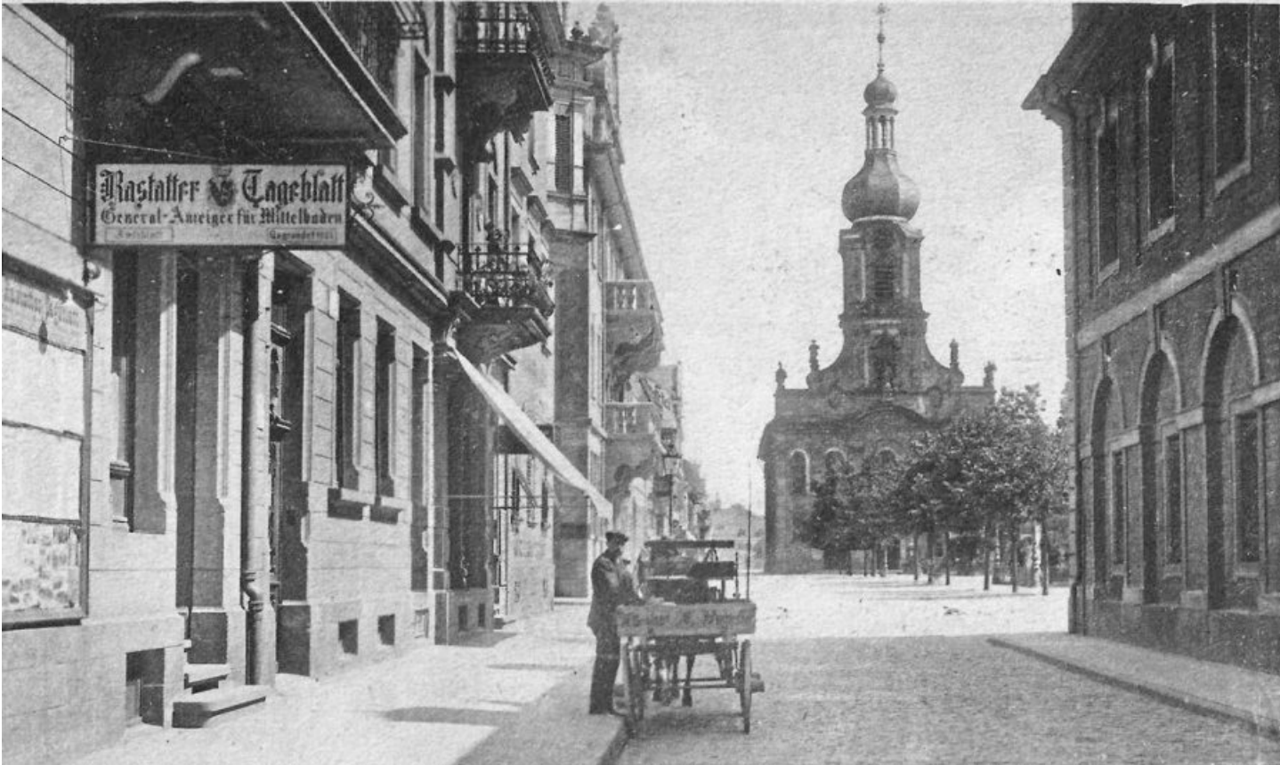
Pressestandort mit Geschichte: In der Kaiserstraße 40 befindet sich über Jahrzehnte der Sitz des Rastatter Tageblatts. Diese Aufnahme stammt aus der Zeit kurz vor dem Ersten Weltkrieg. Foto: Archiv
