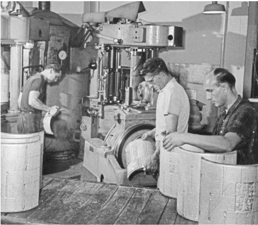
Im Produktionsprozess kommen die flachen Druckformen zunächst in Pressen, in denen aus hitzebeständiger Pappe „Matern“ geprägt werden. In der „Stereotypie“ werden von diesen Negativformen dann halbzylinderförmige Druckplatten abgegossen. Drei Tonnen Metall sind im Kessel, den kräftige Männer in den 1950er Jahren oft zweimal in der Nacht füllen müssen.
