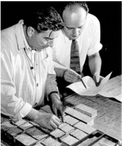
Bleisatz gibt es noch, als Textzeilen schon mit Linotype-Maschinen „gesetzt“ und gegossen werden: Bei Seitenumbruch und Titeln ist Handarbeit angesagt.
