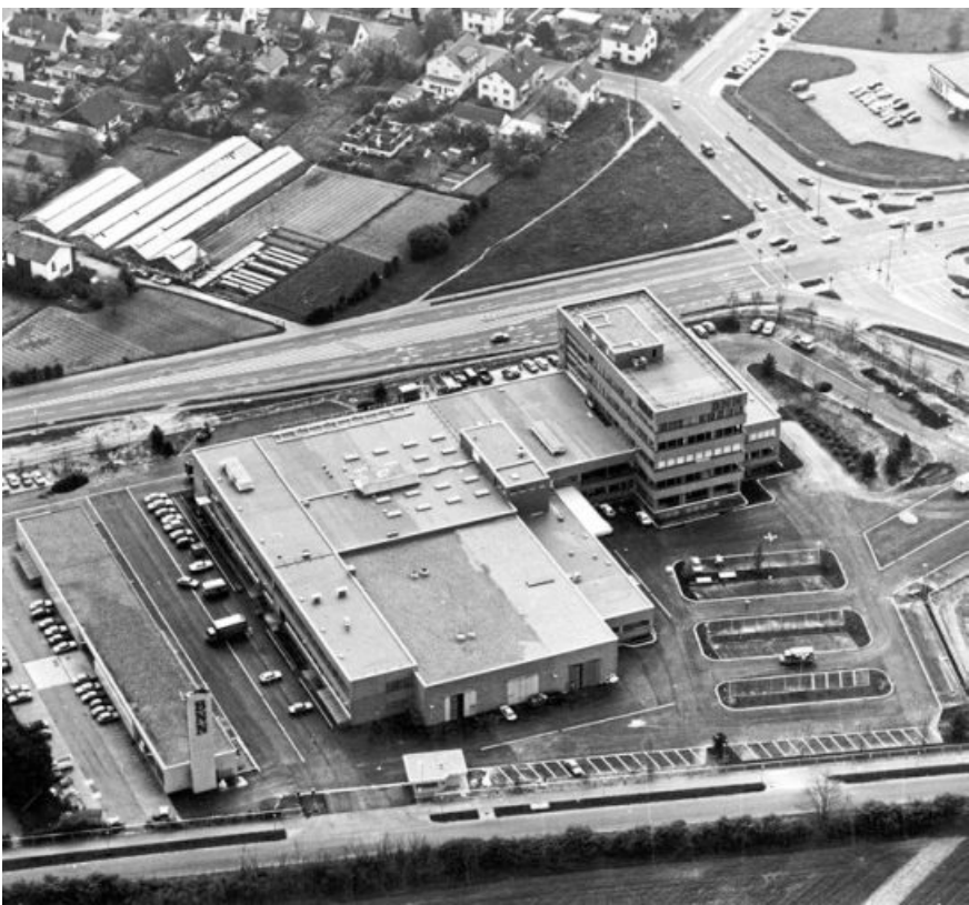
Ab Mai 1986 erfolgt die gesamte Zeitungsproduktion zentral im Verlagsgebäude an der Linkenheimer Landstraße. In der Rekordzeit von 20 Monaten ist der Bau hochgezogen worden. Ein Kilometer Aktenordner, 10.000 Kartons und Hunderte von Schreibmaschinen müssen nach Neureut gebracht werden. Foto: Stadtarchiv Karlsruhe/Schlesiger
